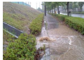
2013.7.4グラウンド西側の様子 大量の土砂が歩道に流出
